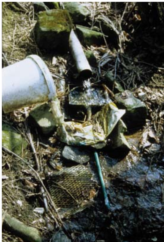
Illegale Ableitung zur Gartenbewässerung.
