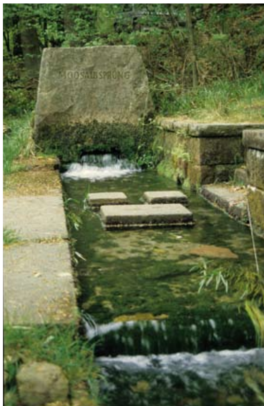
Typen von Quellfassungen: Quellfassung mit Rohr.
